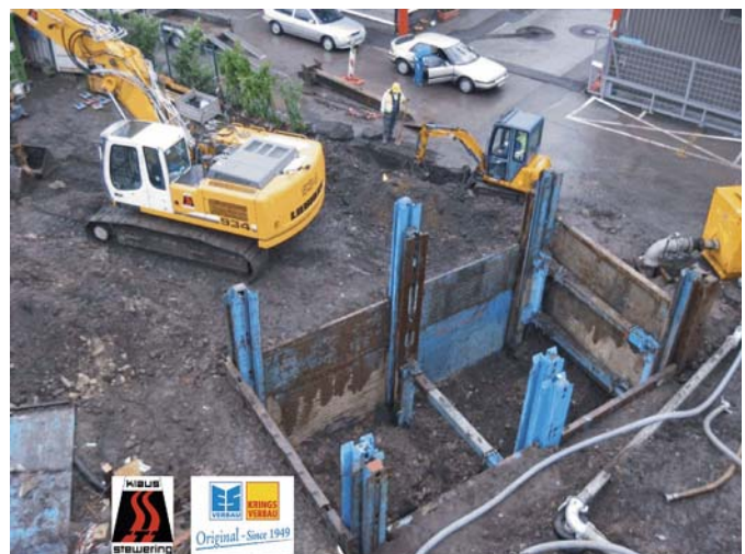
Pierwszy etap – umieszczenie dwóch pól obudowy
