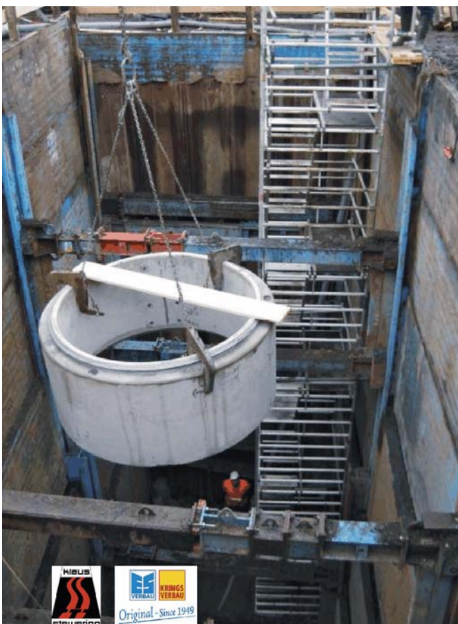
Montaż nowego szybu na pompy na głębokości 14 m
