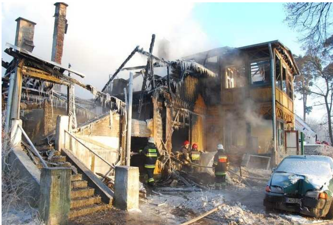
Fot. 8. i 9. Budynki po pożarze
