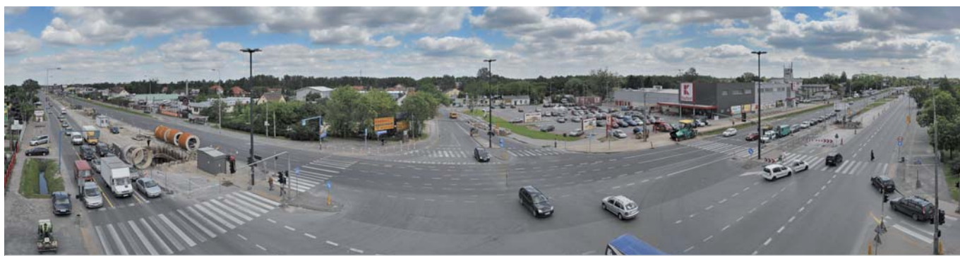
Miejsce wykonania mikrotunelingu
