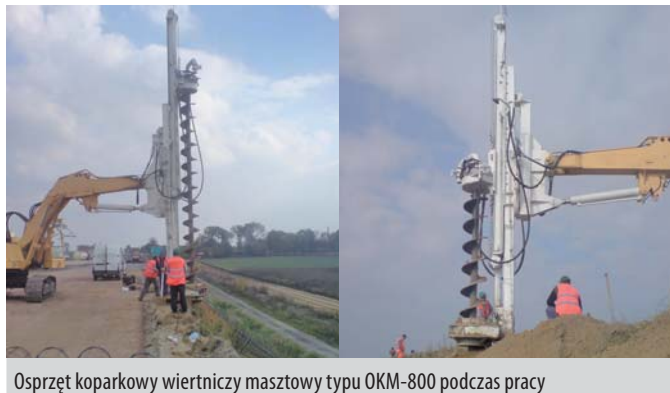
Osprzęt koparkowy wiertniczy masztowy typu OKM-800 podczas pracy
