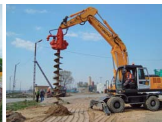
Głowica OWK-4600 ze złączem oraz świdrem CFA
