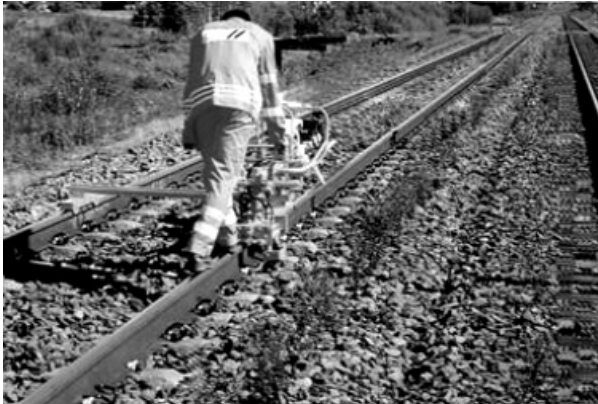
Rys. 29. Ręczny montaż i demontaż przytwierdzenia SB: 1) zapinanie łapki, 2) odpinanie łapki, 3) drążek [Źródło: Instrukcja nr 1/2006 montażu przytwierdzenia sprężystego SB. Vossloh Skamo sp. z o.o. Nowe Skalmierzyce, 2006]
