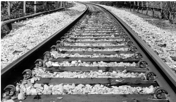
Rys. 26. Tor na podkładach drewnianych z przytwierdzeniem SD3
