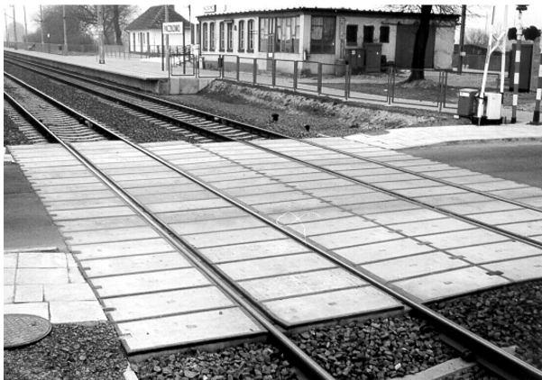
Rys. 25. Przejazd typu Mirosław Ujski na linii Warszawa – Poznań
