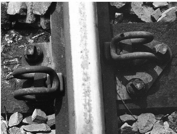
Rys. 27. Szczegół przytwierdzenia SD3
