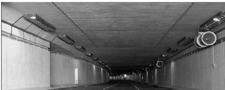
Fot. 5 Widok tunelu drogowego w Warszawie na Wisłostradzie [9].
