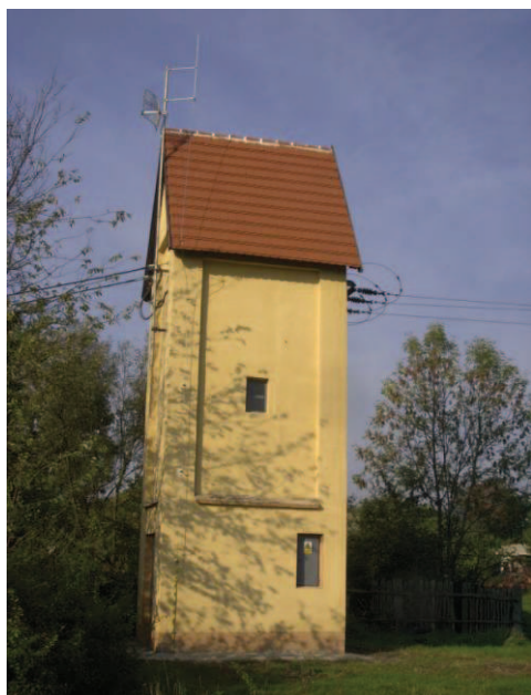
Rys. 4. Stacja transformatorowa – ochrona odgromowa systemu antenowego
