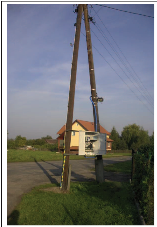
Rys 1. Przykładowa lokalizacja koncentratora na słupie linii elektroenergetycznej niskiego napięcia
