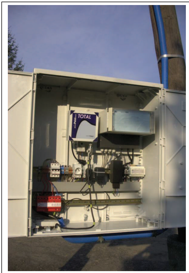
Rys 1. Przykładowa lokalizacja koncentratora na słupie linii elektroenergetycznej niskiego napięcia
