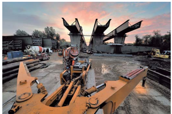
Betonowanie podpory P50 o świcie, fot. S. Klorek, wł. archiwum CEMEX Polska
