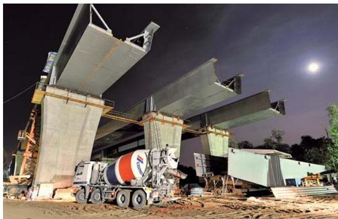
Filary i konstrukcja stalowa na podporze P60, fot. S. Klorek, wł. archiwum CEMEX Polska
