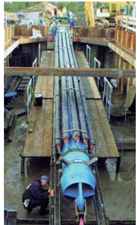
Ryc. 5. Montaż pierwszych rur wprowadzanych do tunelu wieloprzewodowego [5]
