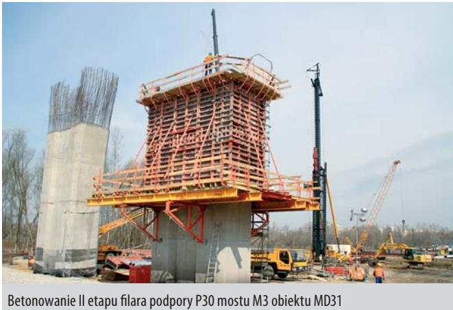
Betonowanie II etapu filara podpory P30 mostu M3 obiektu MD31
