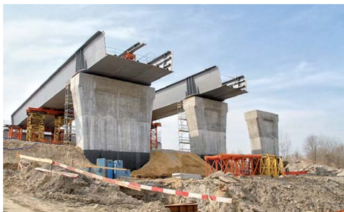
Widok na podporę 20 mostu MD31 – konstrukcja stalowa przęsła 10–20 na mostach M2 i M3 w trakcie montażu
