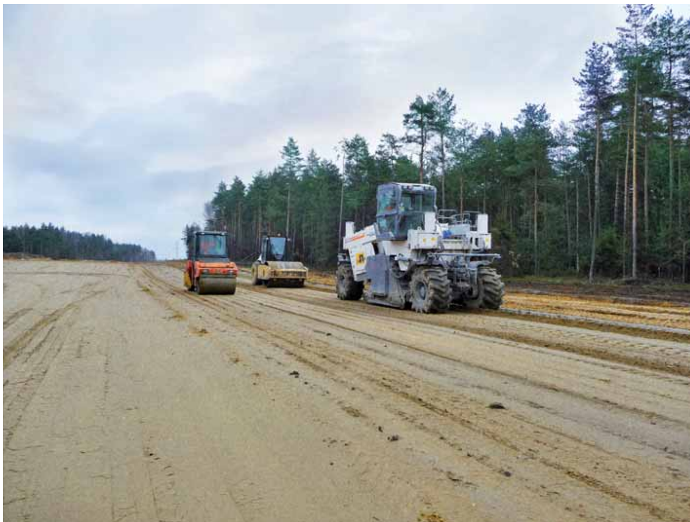
Ryc. 2. Równanie i dogęszczanie warstwy nasypu stabilizowanej spoiwem Silment CQP-15
