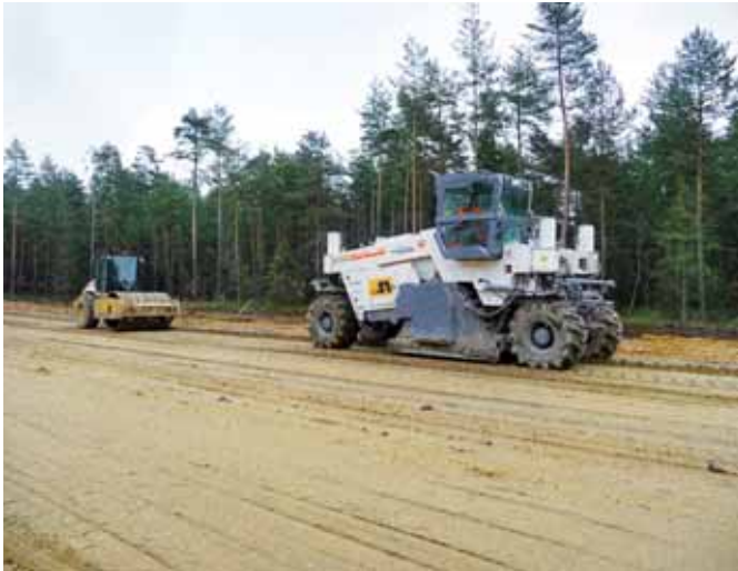
Ryc. 3. Stabilizacja podłoża autostrady A1 Sośnica – Gorzyczki na odcinku od węzła Bełk (bez węzła) do węzła Świerklany
