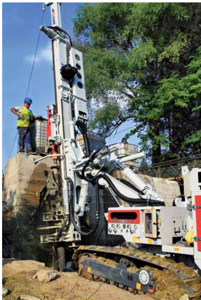
Ryc. 4. Wiertnica MC 800 podczas procesu wiertniczego wokół adaptowanych przyczółków mostu
