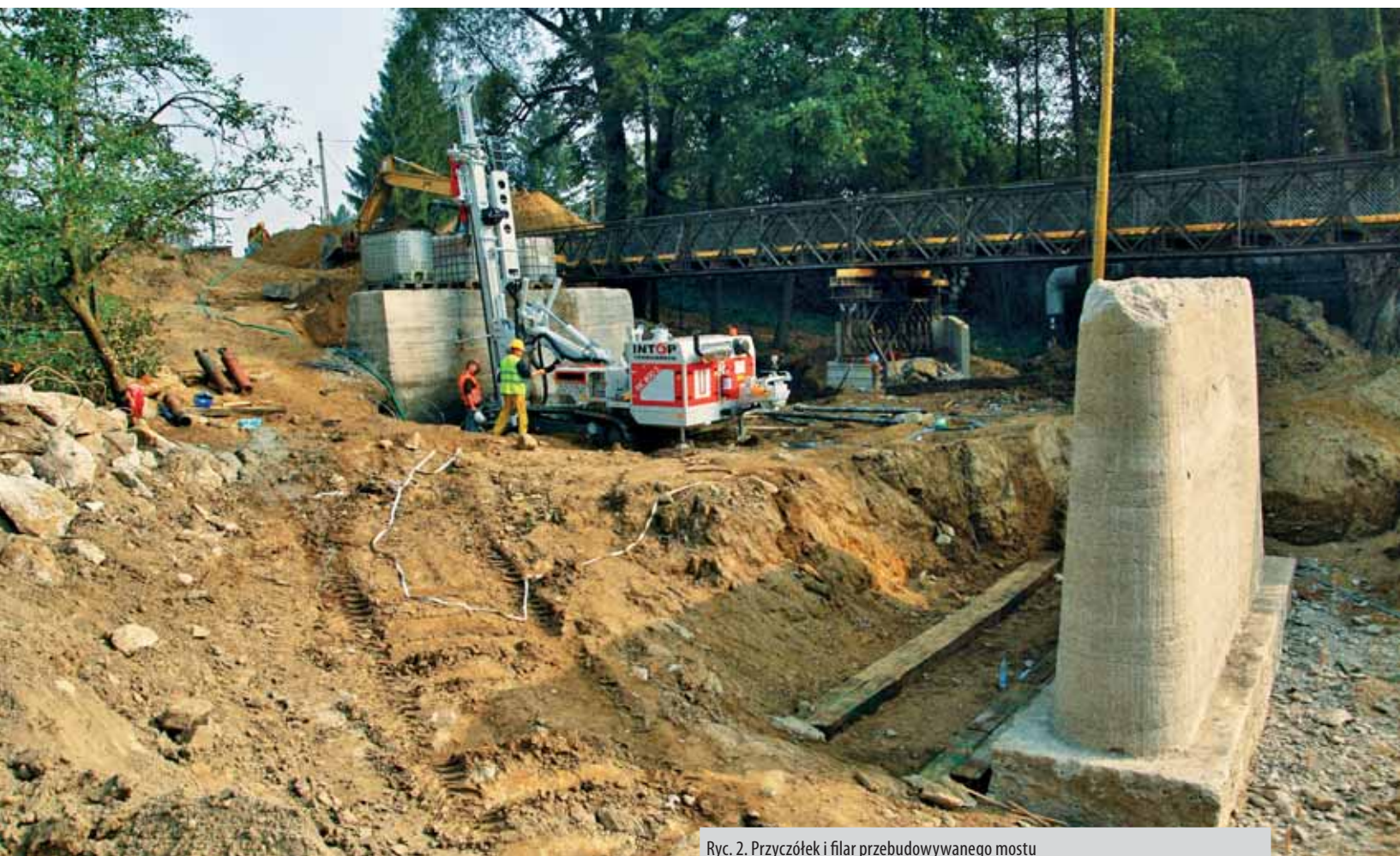
Ryc. 2. Przyczółek i filar przebudowywanego mostu
