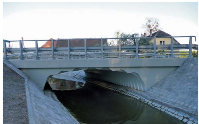
Przykładowy zrealizowany obiekt drogowy z wykorzystaniem konstrukcji podatnych – stalowych blach falistych
