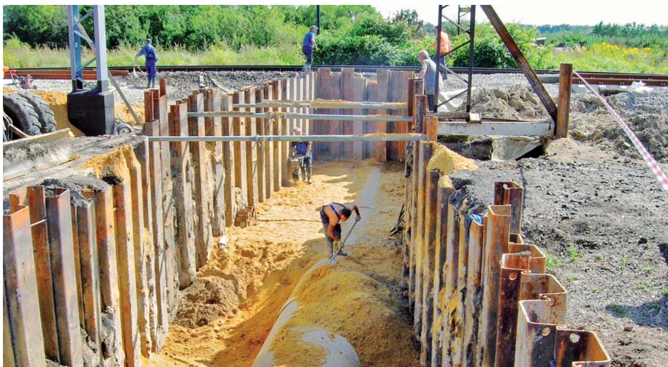
Zagęszczanie obsypki rur CC-GRP DN1800
