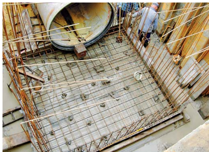
Włączenie rury do komory betonowej
