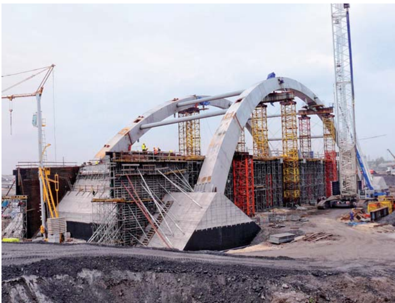
WD 464 Deskowanie skrzydeł przyczółka i rusztowanie ustroju
