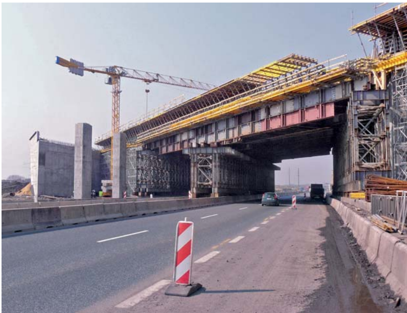
WA 466 2.2 Rusztowanie i deskowanie ustroju nośnego
