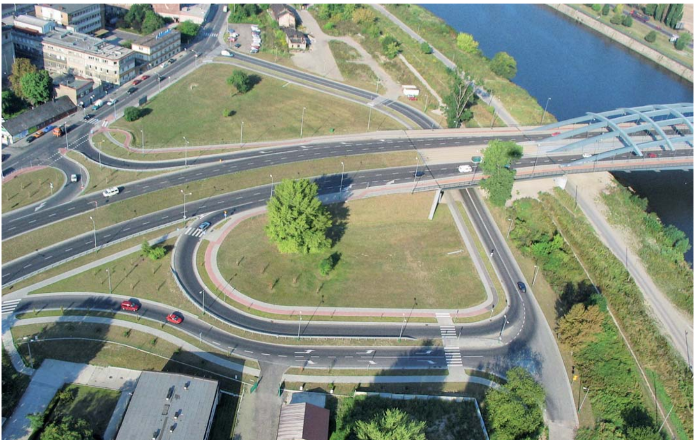
Dojazd do mostu Kotlarskiego wraz z węzłem drogowym
