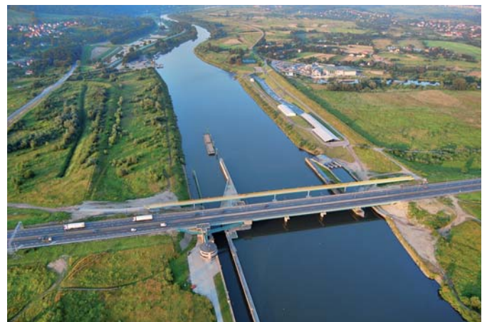
Most autostradowy na stopniu wodnym Kościuszko wraz z kładką dla pieszych. W tle tor kajakowy
