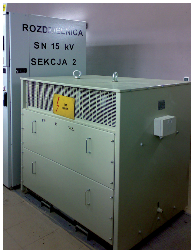
Fot. 1. Nowy transformator potrzeb własnych – stacja „Zgierska”
