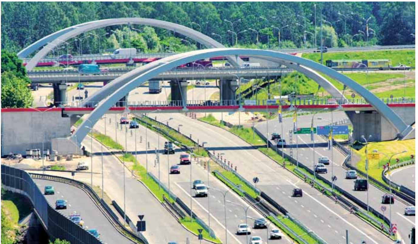
Węzeł Murckowska w Katowicach
