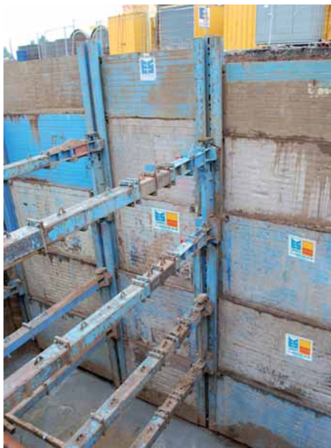
Głęboka obudowa liniowa do 14 m głębokości
