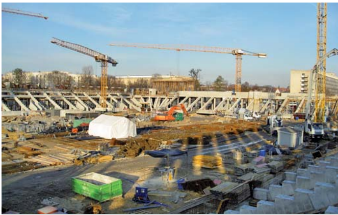
Budowa stadionu, stan z listopada 2009 r.
