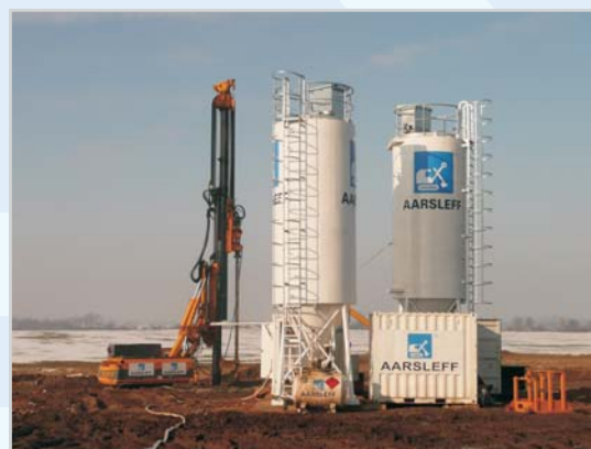
Zachodnia Obwodnica Poznania - wzmocnienie podłoża kolumnami DSM
