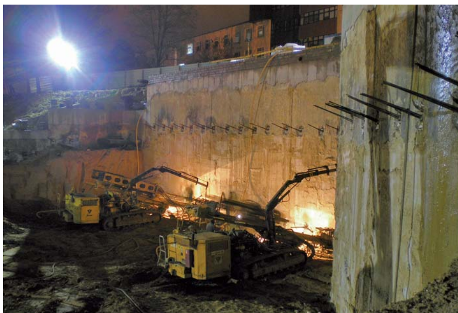
Budowa kompleksu sportowego Akademii Rolniczej w Lublinie. Ściana szczylinowa kotwiona dwoma rzędami kotwi stalych systemu SUSPA-Daueranker, Stump - Hydrobudowa Sp. z o.o.
