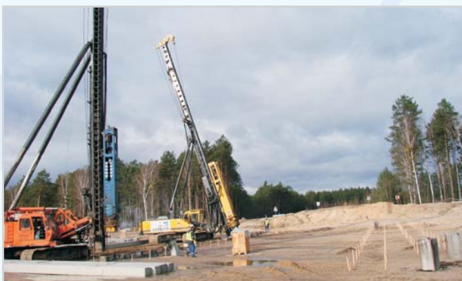
Autostrada A2, Świecko - Nowy Tomyśl - pale prefabrykowane
