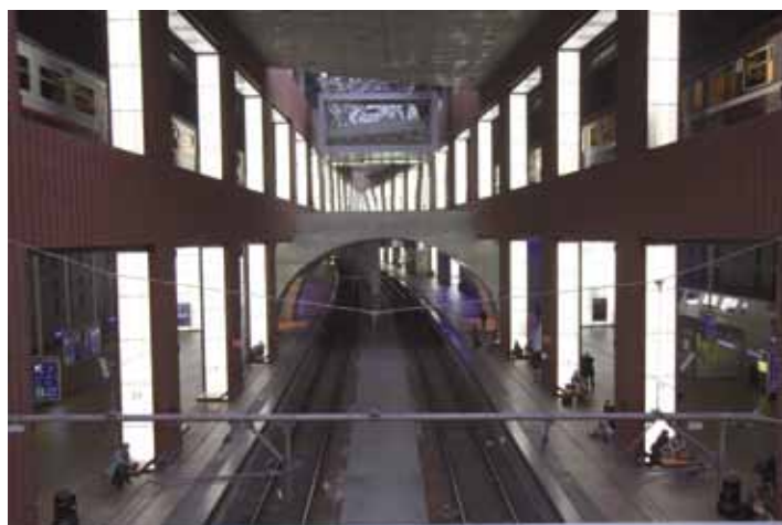
Fot. 6. Widok na poziom -2 i -1. Poziom -2 to tunel, przez który przejeżdżają pociągi w relacjach dalekobieżnych. Poziom -1 wykonany w układzie czołowym i odjeżdżają stąd wyłącznie ezt (29.10.2009 r.)
