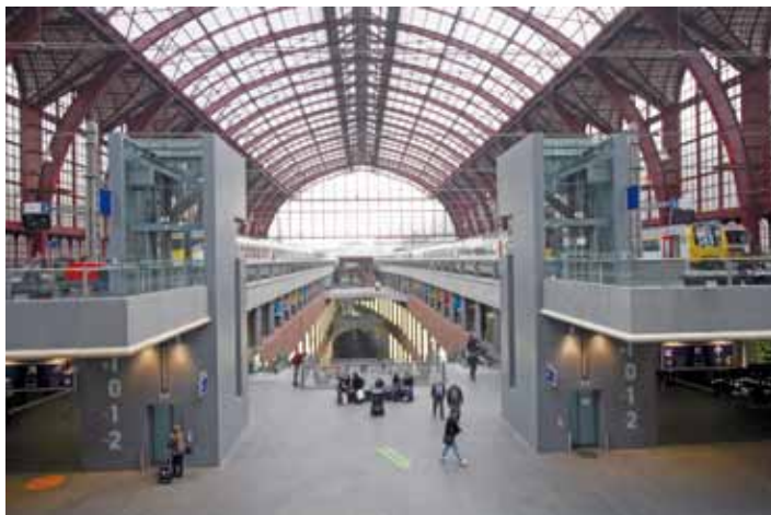
Fot. 4. Widok na przebudowaną halę. Po obu stronach na estakadach (poziom +1) znajdują się perony, z których odjeżdżają pociągi lokalne obsługiwane ezt, oraz niektóre pociągi międzynarodowe (np. do Essen 14.35). Poniżej na poziomie „0” widoczne zejścia na poziom -1 i -2. Cały kompleks wyposażony jest w windy dla osób niepełnosprawnych (29.10.2009 r.)
