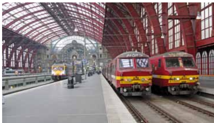
Fot. 5. Perony na poziomie +1, w głębi widoczna tylna fasada „starego” budynku (29.10.2009 r.)
