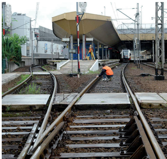
Rys. 1. Fragment inwentaryzowanego toru nr 9 i 11 oraz sposób przykładania reflektora pryzmatycznego do toku szynowego
