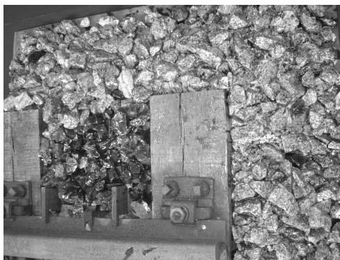
Rys. 14. Warstwa podsypki stabilizowanej chemicznie żywicą poliuretanową [fot. J. Kukulski]
