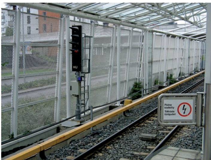
Sygnalizacja i trzecia szyna zasilająca, stacja Vuosaari (Nordsjö, 6.09.2009 r.)
