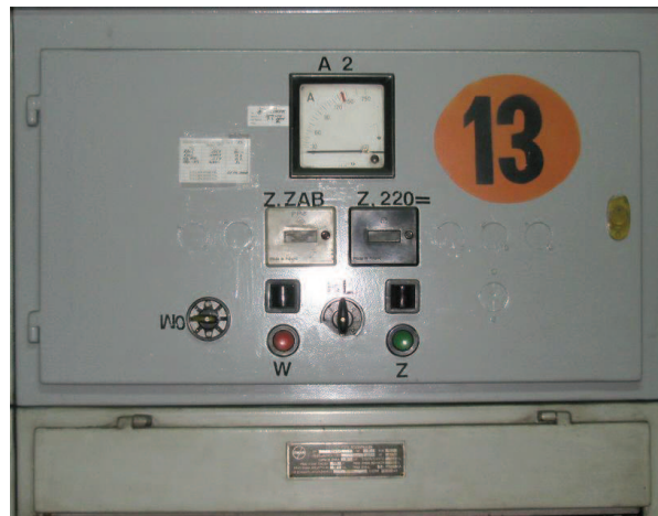
Rys 1. Widok drzwi celki n/n rozdzielnic RSW przed modernizacją
