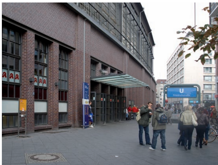
Wyjście z budynku dworca Friedrichstraße
