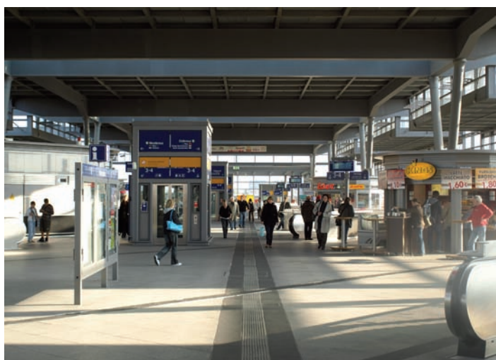
Stacja Berlin Süd – górny peron kolei S-Bahn, leżący na kierunku wschód–zachód nad torami kolei DB i S-Bahn biegnącymi w kierunku północ–południe
