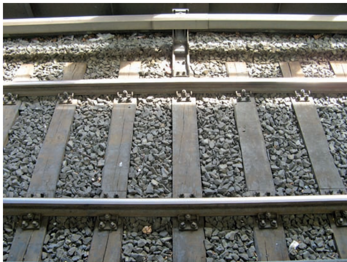
Szyna zasilająca (13.06.2009 r.)
