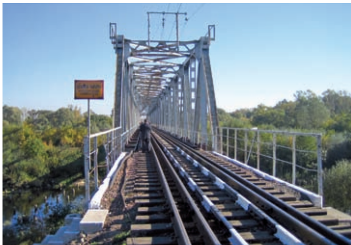
Fot. 8. Kontrola stanu technicznego kolejowego mostu granicznego na kolejowym przejściu granicznym Terespol (Polska) – Brześć (Białoruś)
