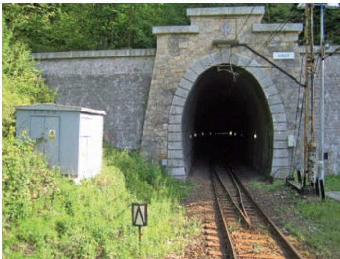
Fot. 2. Tunel liniowy na stacji Tunel na linii Warszawa – Kraków
