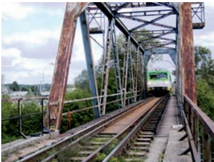
Rys. 7. Pociąg osobowy, pobudzający konstrukcję mostu do odpowiedzi dynamicznej Fot. archiwum IPPT PAN
