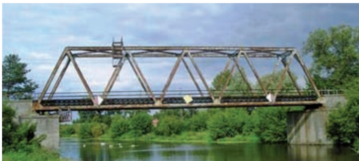
Fot. 5. Most kolejowy nad Kanalem Żerańskim w Nieporęcie, poddawany badaniom Fot. archiwum IPPT PAN
