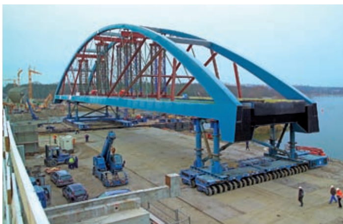
Fot. 10. Odbudowa nowego kolejowego mostu granicznego na przejściu granicznym Kunowice (Polska) – Frankfurt/Oder (Niemcy)
