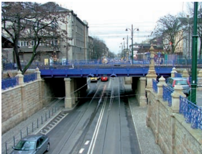
Fot. 1. Zmodernizowany wiadukt kolejowy nad ul. Lubicz w Krakowie
