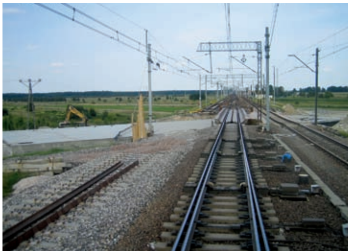
Fot. 3. Modernizowany wiadukt kolejowy w Psarach na linii CMK
