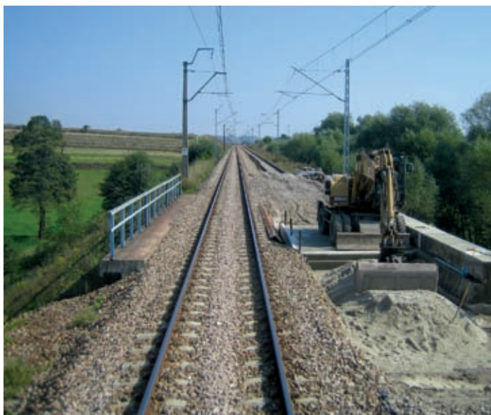
Fot. 4. Modernizacja wiaduktu kolejowego na linii kolejowej Warszawa – Kraków
