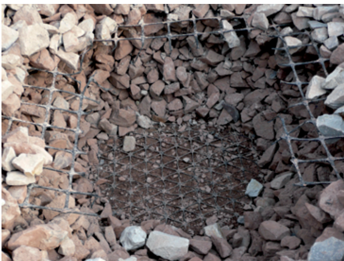
Rys. 1. Stanowiska do pomiaru modułów podtorza – zbrojenie podsypki geosiatką i geowłókniną na torowisku, podsypka wzmocniona geosiatkami
