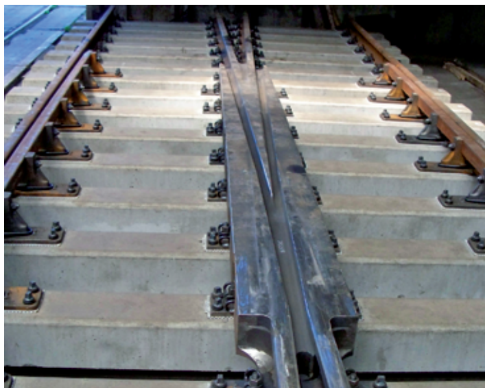
Rys. 9. Krzyżownica blokowa rozjazdu Rz 60E1-760-1:14 KZN „Biezanów”
