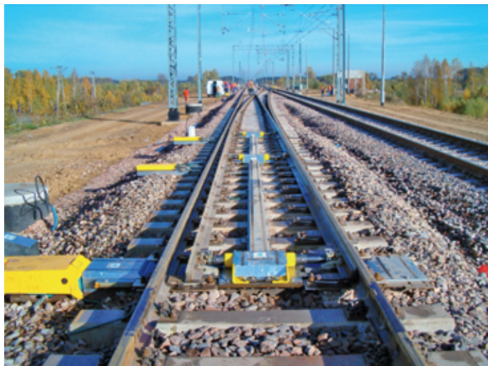
Rys. 4. Zwrotnica rozjazdu VAE Rz 60E1-1200 – 1:18,5
