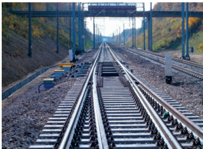
Rys. 5. Zwrotnica rozjazdu „1200” firmy COGIFER w odmianie Integrated Roding
