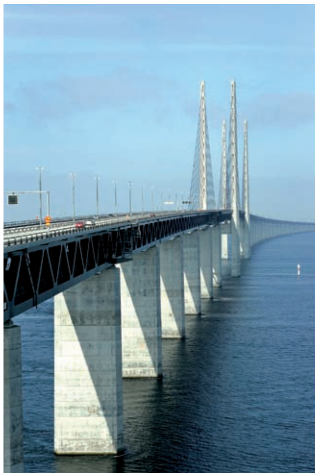
Most Øresund, na dolnym poziomie biegnie linia kolejowa, 5.05.2005 r.
