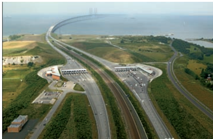
Wjazd na most od strony Szwecji, widoczna jest linia kolejowa biegnąca środkiem oraz autostrada dla samochodów po obu stronach torów, które – przez osiągnięciem mostu – schodzą do tunelu, aby bieć po dolnym poziomie mostu, 16.07.2003 r.
