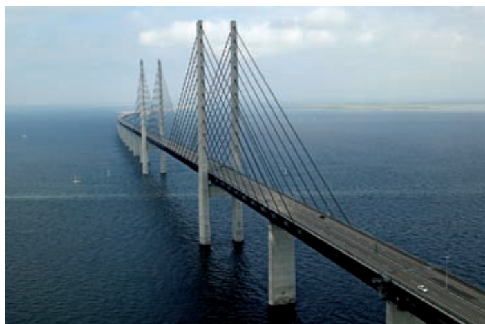
Część wisząca mostu utworzona przez 4 pylony w kształcie litery H, o wysokości ponad 200 m
