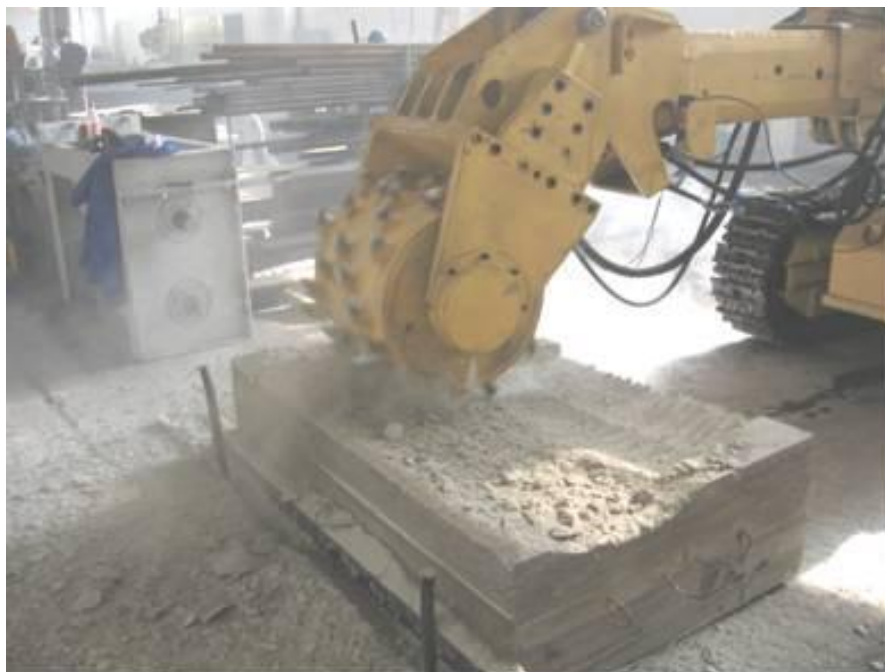
Rys. 9. Widok ładowarki z organem frezującym podczas prób urabiania bloku betonowego
