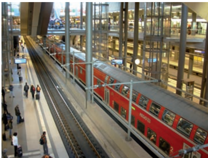
Fot. 5. Dworzec Berlin Hauptbahnhof – perony górnej platformy kierunku wschód–zachód i perony dolne w kierunku północ–południe
