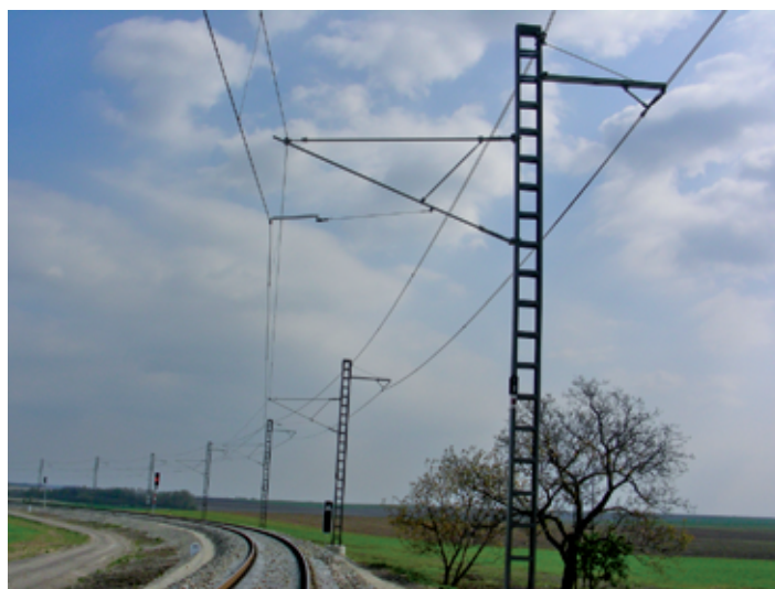
Rys. 15. Lina ochronna służąca również do odprowadzenia prądu powrotnego 2 \times 120\text{Cu} Šatov – granica Republiki Czeskiej/Austrii (system austriacki 15 kV 16,7 Hz)
