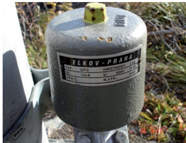
Rys. 7. Iskiernik działania wielokrotnego
