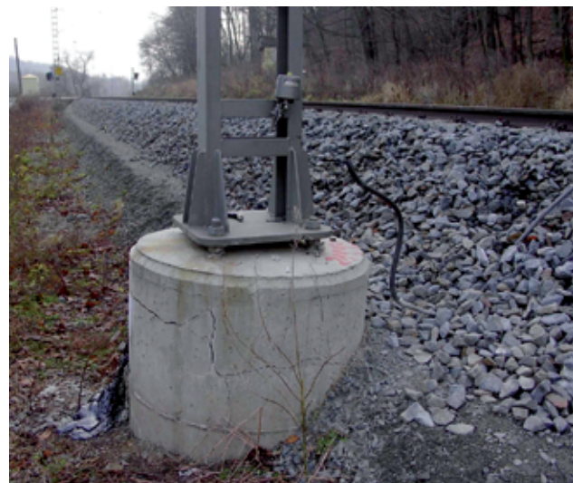
Rys. 20. Skutki awarii przy braku uszynienia
