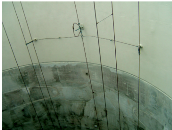
Rys. 14. Szczegóły połączenia podwieszeń przewodu wzmocniającego linę 50Bz
