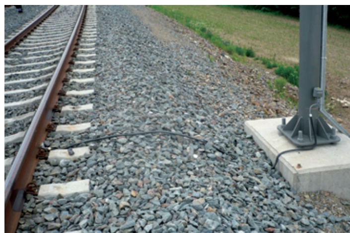
Rys. 8. Typowe uszynienie stupa przez iskiernik
