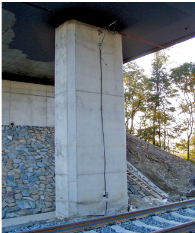
Rys. 11. Uszynienie podwieszenia przewodu wzmocniającego pod wiaduktem
