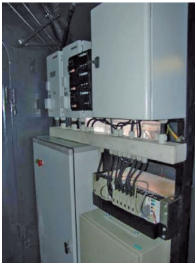
Rys. 31. Generator CA i SHP, zespoły radia Koliber i jednostka centralna prędkościomierza Metra
