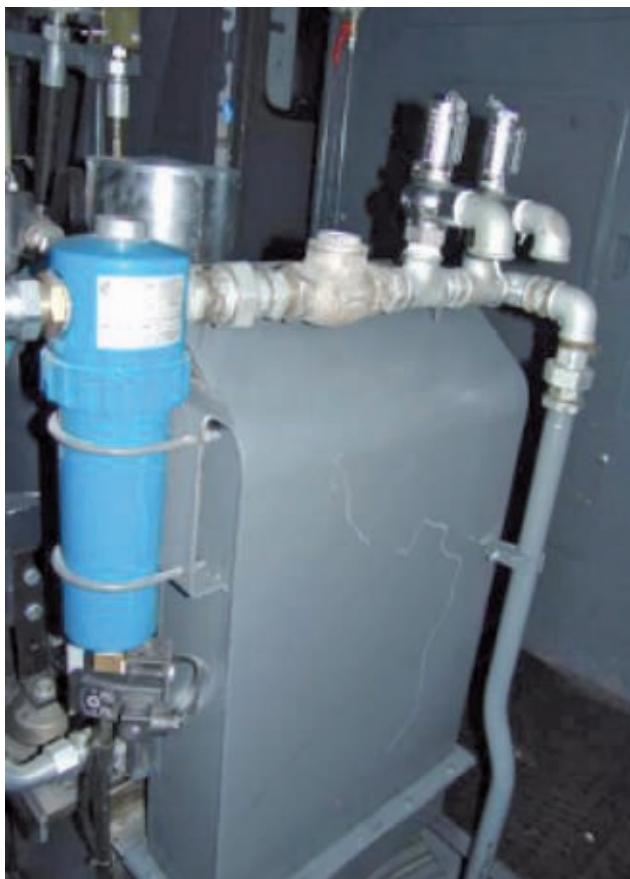
Rys. 29. Filtr cyklonowy z automatycznym spustem kondensatu, zawór zwrotny i zawory bezpieczeństwa
