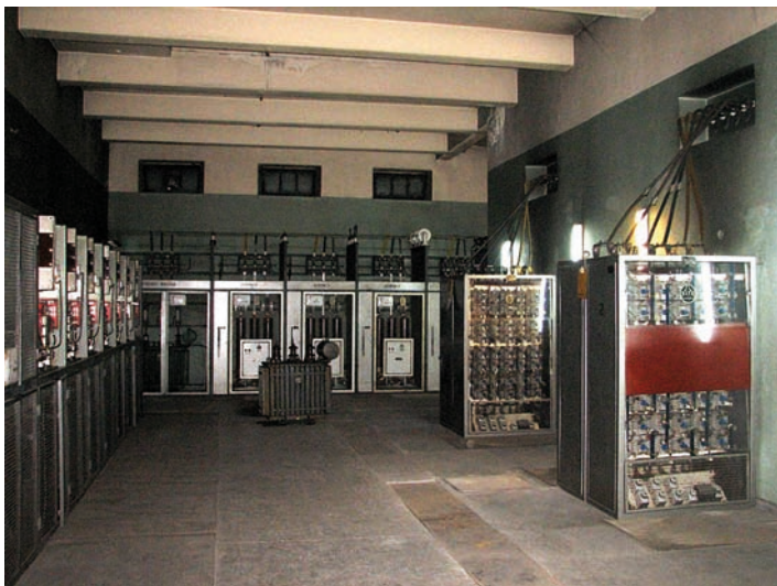
Hala główna podstacji przed przebudową
