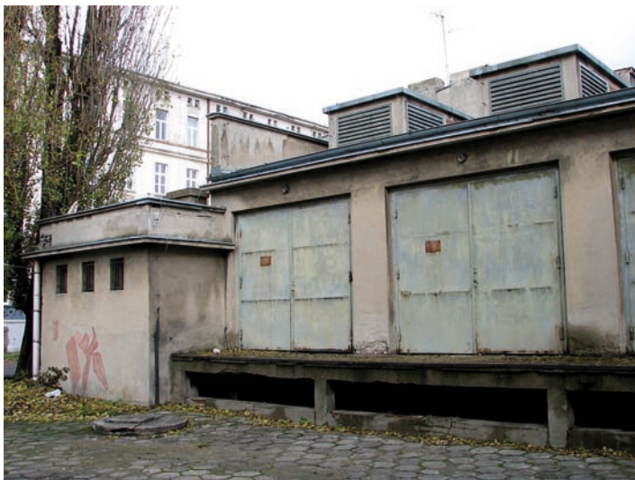
Budynek stacji prostownikowej przed remontem
