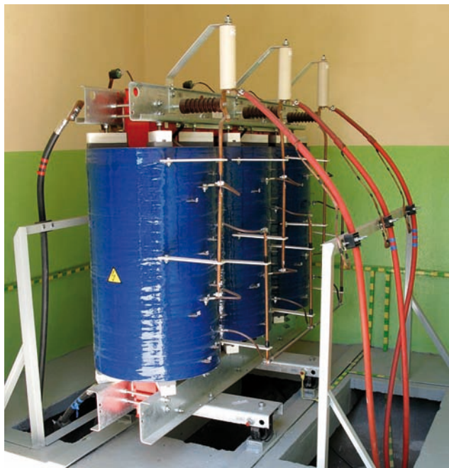
Transformator prostownikowy TZM3T-1200/15
