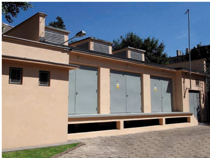
Budynek stacji prostownikowej po remoncie
