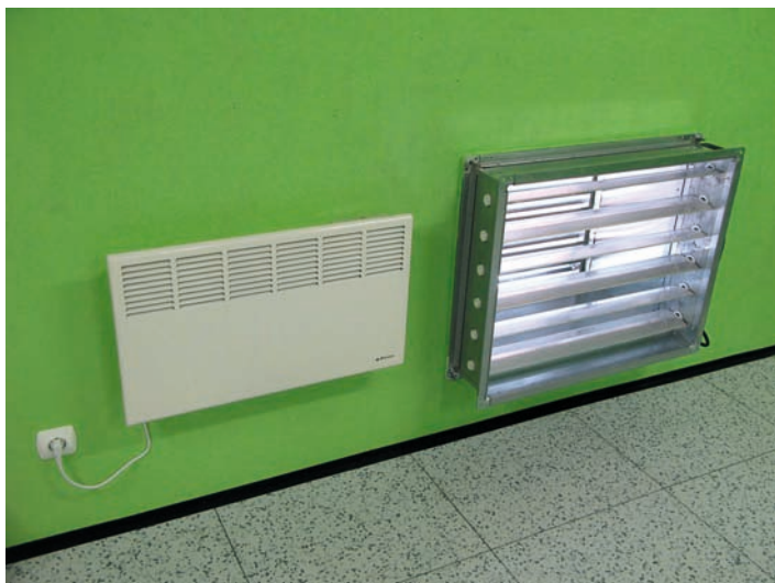
Grzejniki panelowe i elektrycznie sterowane żaluzje
