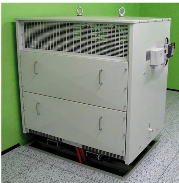
Transformator potrzeb własnych w obudowie IP23
