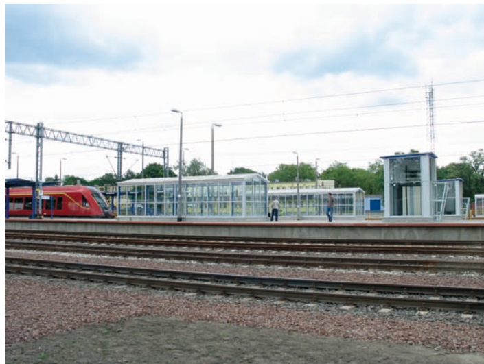
Fot. 10. Perony stacji Koluszki po modernizacji
