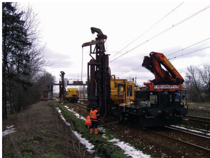
Fot. 11. Instalacja prefabrykowanych pali fundamentowych pod słupy konstrukcji wsporczej trakcyjnej kolejowej
