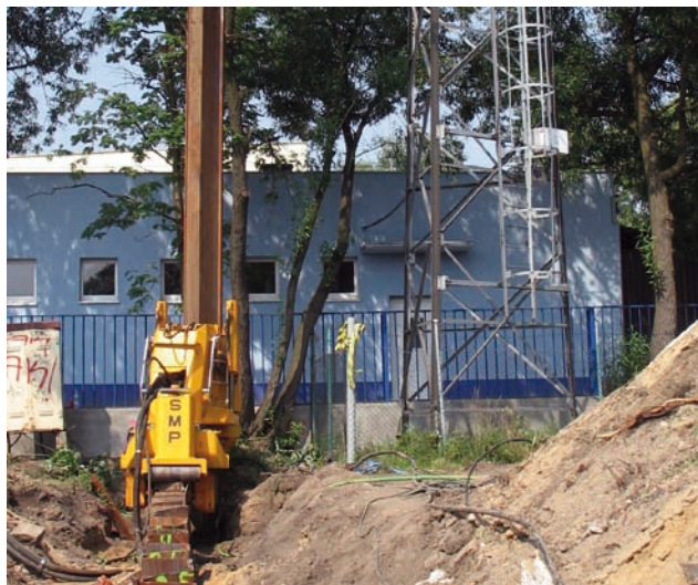
Fot. 4. Instalacja grodzic stalowych metodą wciskania
