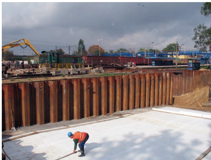
Fot. 6. Zabezpieczenie odcinka tunelu na etapie wykonania płyty dennej
