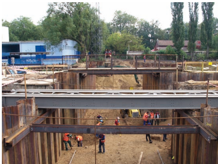
Fot. 8. Zabezpieczająca ścianka szczelna oraz tymczasowa konstrukcja kolejowa w fazie budowy
