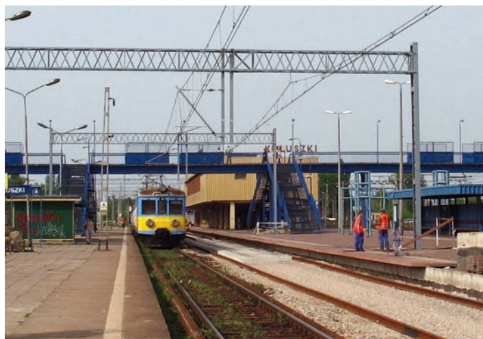
Fot. 1. Dotychczasowe przejście dla pieszych
