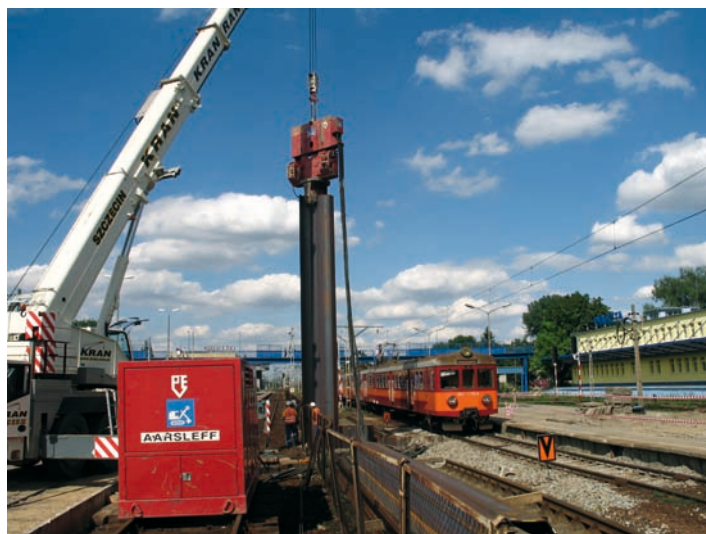
Fot. 3. Instalacja grodzic metodą wibracyjną wzdłuż czynnego toru kolejowego
