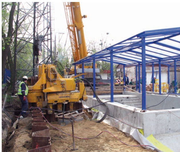
Fot. 5. Bezwibracyjny demontaż grodzic bezpośrednio przy wybudowanej konstrukcji wejścia do tunelu
