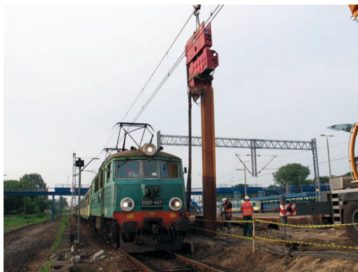
Fot. 2. Instalacja stalowej ścianki szczelnej metodą wibracyjną przy czynnym torze kolejowym
