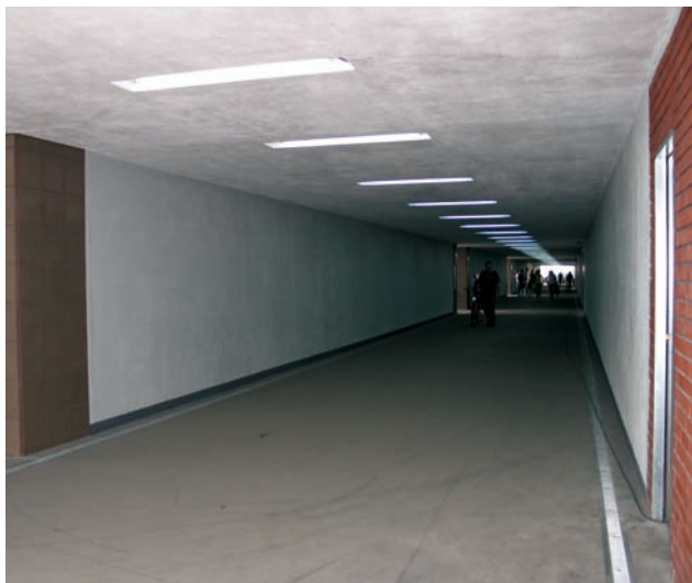
Fot. 9. Efekt prowadzonej budowy – przejście oddane do eksploatacji
