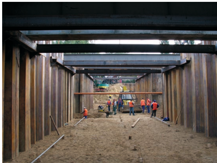
Fot. 7. Faza wykonania wykopu docelowego zabezpieczonego ścianami szczelnymi
