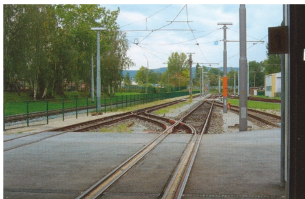
Rys. 41. Widok z hali na tor próbny; po lewej długi tor
