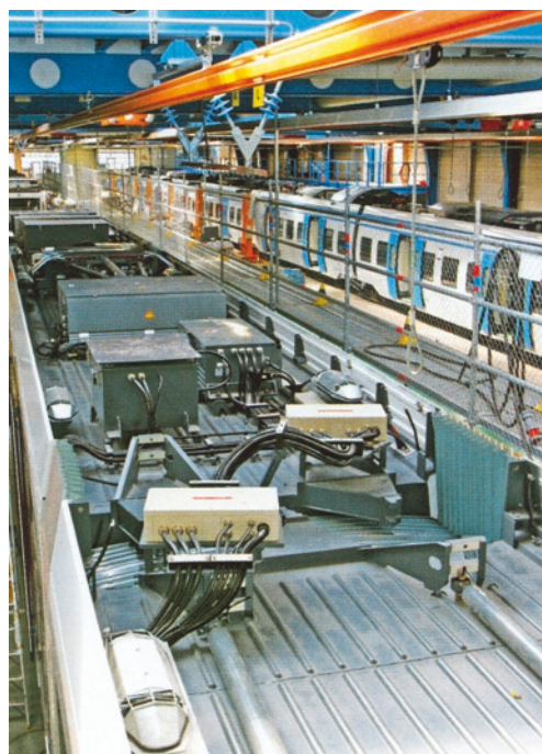
Rys. 14. Braunschweig, dach z podporami dla wsporników kotłowania poprzecznego oraz dwoma jeszcze nie zabudowanymi amortyzatorami wzdłużnymi i urządzeniami elektrycznymi BT
