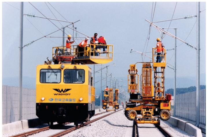
Zawieszanie i regulacja sieci trakcyjnej
