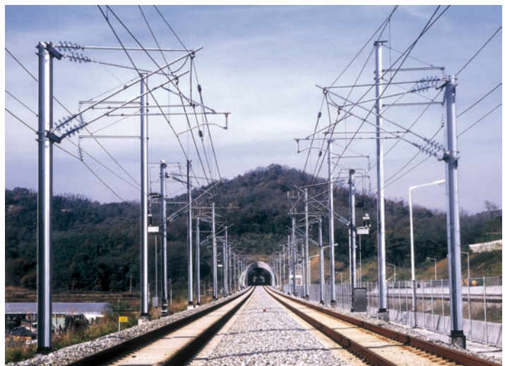
Koreańska linia dużych prędkości – zwraca uwagę sieć trakcyjna, zbudowana zgodnie z francuskimi parametrami technicznymi, oraz podsypka tłuczniowa
