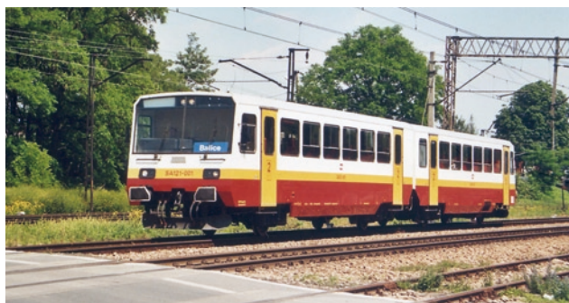
Pierwsze tygodnie kolejowego połączenia z lotniskiem, najstarszy pojazd SA101-001 na wyremontowanym odcinku linii 133 w rejonie posterunku Kraków Łobzów Fot. P. Terczyński
