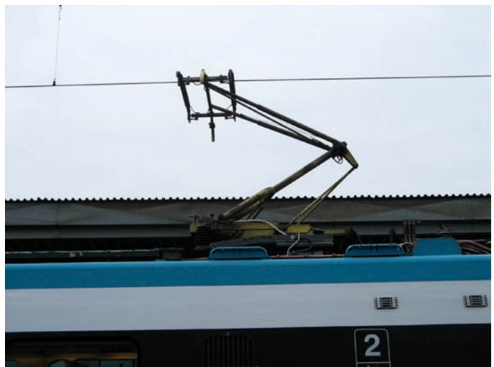
Pantograf 3 kV DC, dworzec Holešovice (Praga, 8.03.2008 r.)
