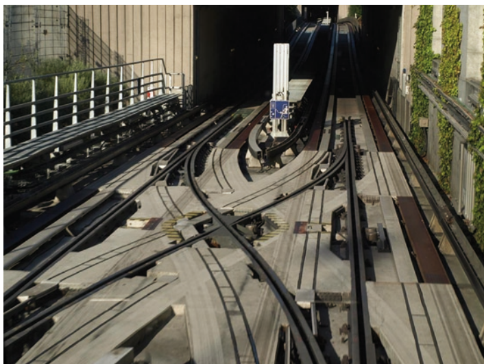
Przejazd krzyżowy ułatwiający zmianę kierunku jazdy między każdą stacją. Biało-granatowa tablica informuje o drodze ewakuacyjnej
