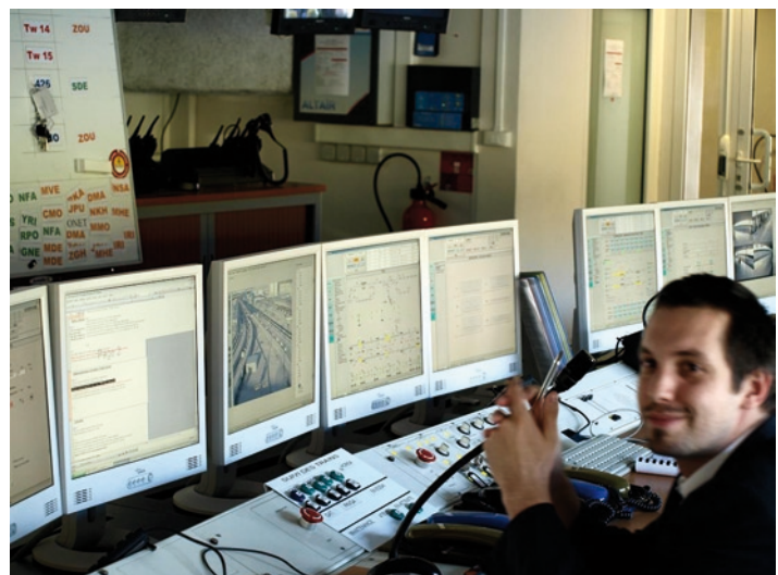
Stanowisko pracy operatorów w punkcie centralnego zarządzania PCC
