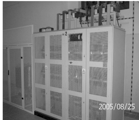
Rys. 5. Prostownik diodowy — część zespołu typu PD17
