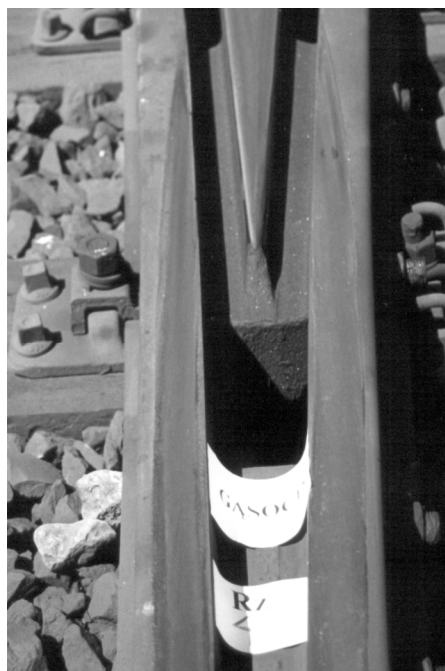
Rys. 18. Krzyżownica z wymiarem f = 1381,7 mm ( e = 1435 - 2 ; h = 51,3 mm, prawdopodobna wartość zaczepienia koła wynosi 10,3 mm); lewa powierzchnia boczna nosi ślady uderzeń kół od samego początku dzioba, dziób nie jest jednak zniekształcony; dość równomierny ruch po obu torach
