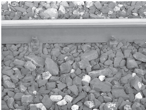
Rys. 7. Bardzo grubo tłuczeń z różnych skał (linia Warszawa – Lublin, odcinek Otwock – Piława)
