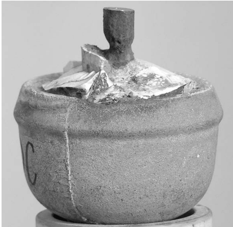
Rys. 8. Ubytki materiału trzonka i kołpaka izolatora kołpakowego spowodowane korozją
