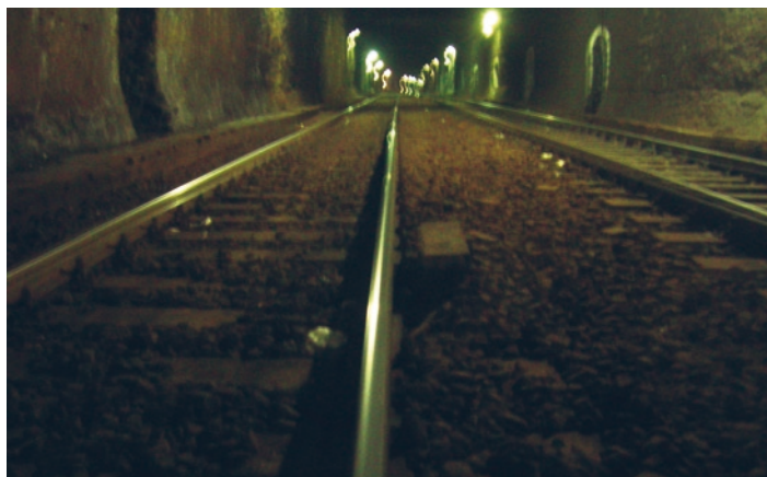
Fot. 2. Nawierzchnia klasyczna w tunelu średnicowym
