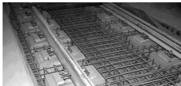
Fot. 7. Zbrojenie górne po ułożeniu maty wibroizolacyjnej i bloczków EBS
