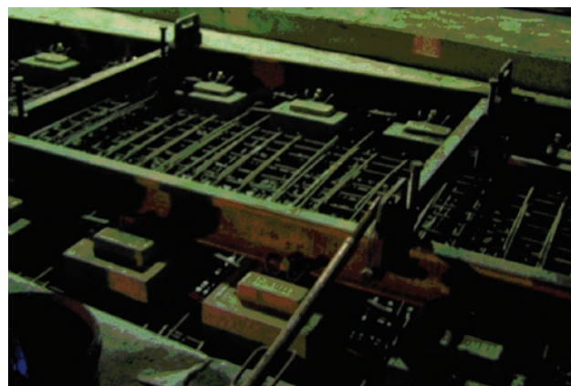
Fot. 8. Tor wyregulowany w planie i profilu, przygotowany do betonowania
