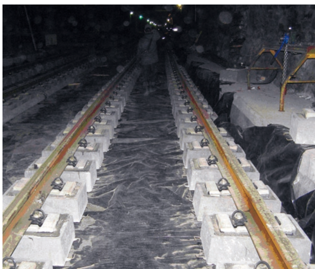
Fot. 6. Mata wibroizolacyjna wraz z folią zabezpieczającą
