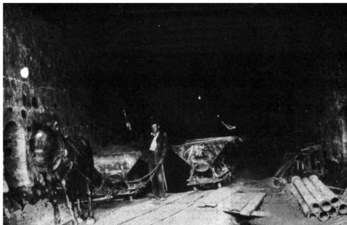
Fot. 1. Budowa tunelu średnicowego w latach 30. XX w.
