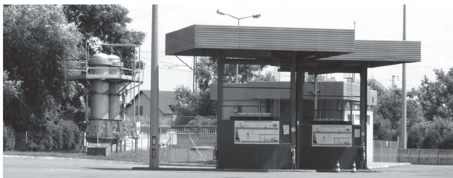
Rys. 5. Widok stacji tankowania sprężonego gazu w MZK Przemyśl.
