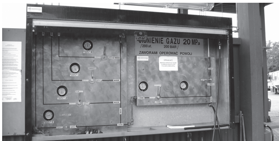
Rys. 9. Tablica sterownicza stanowiska do tankowania CNG w MZK Przemyśl.
