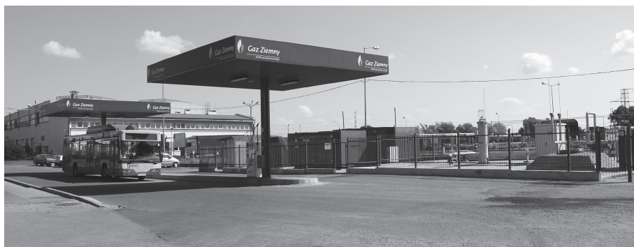
Rys. 4. Widok ogólny stacji MPK oraz autobus Jelcz M125M/4 CNG podczas tankowania.
