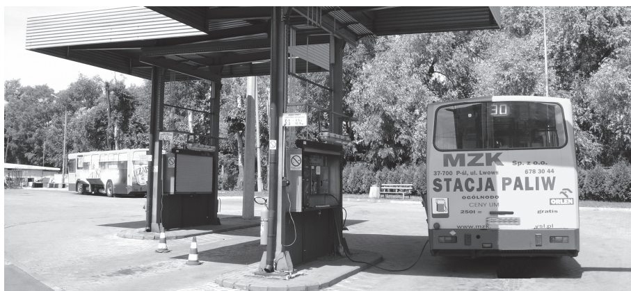
Rys. 10. Stanowiska do tankowania CNG w MZK Przemyśl.
