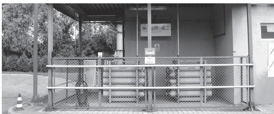
Rys. 8. Magazyn sprężonego gazu ziemnego. Fig 8. Cascades storage.
