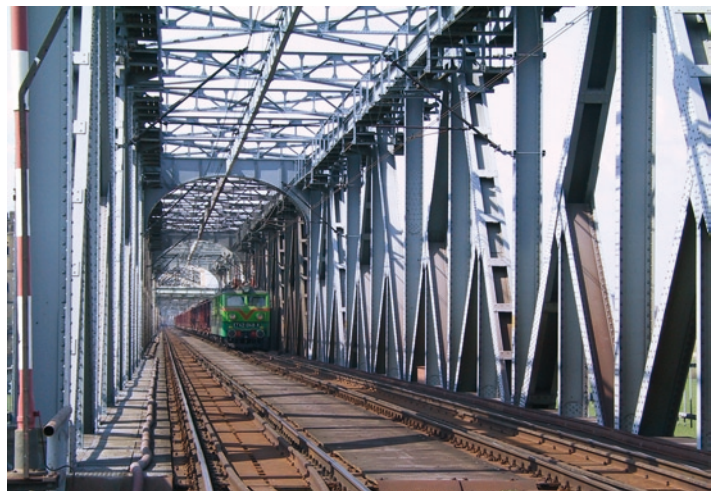
Most kolejowy nad terenami rozlewowymi rzeki Wisły, położony 30 m poniżej mostu z 1857 r.
