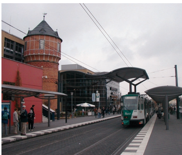
Fot. 17. Poczdam, węzeł przy dworcu Potsdam Hauptbahnhof – widok z przystanków tramwajowych Fot. autor, 2005
