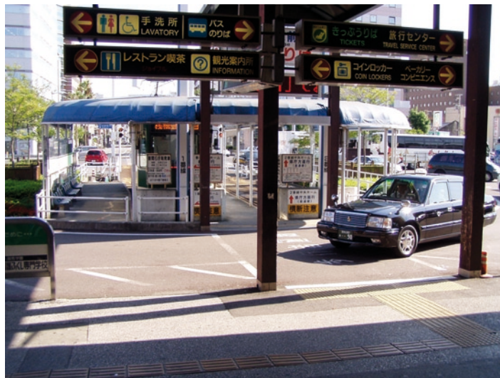
Rys. 26. Kōchi – dojście do dwutorowej krańcówki przed dworcem JR Kōchi
