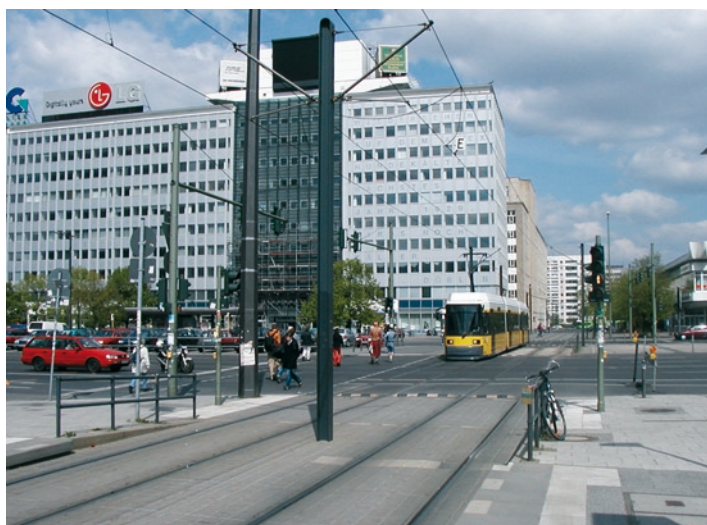
Rys. 15. Berlin – linia tramwajowa na Alexanderplatz – przejazd jednopoziomowy przez dwujezdniową arterię ulokowany między skrzyżowaniami Fot. autor, 2005
